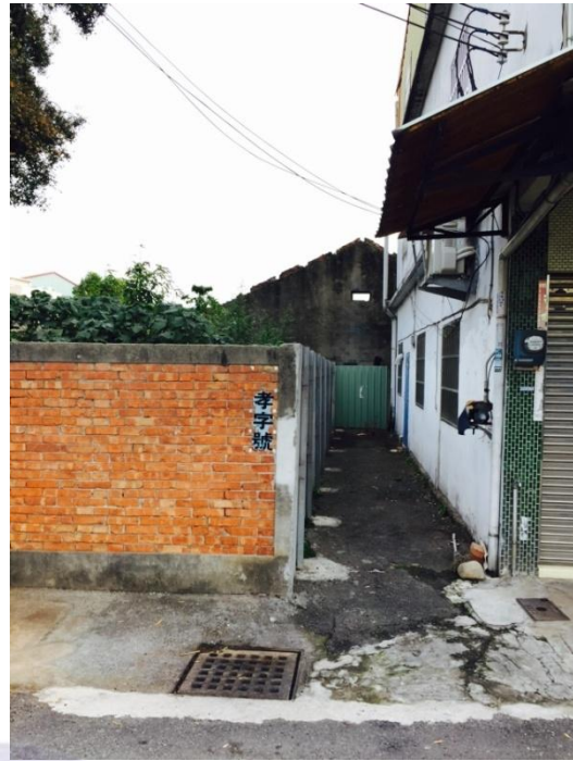
照片 4 日式眷舍外觀(孝字號已毀損)
